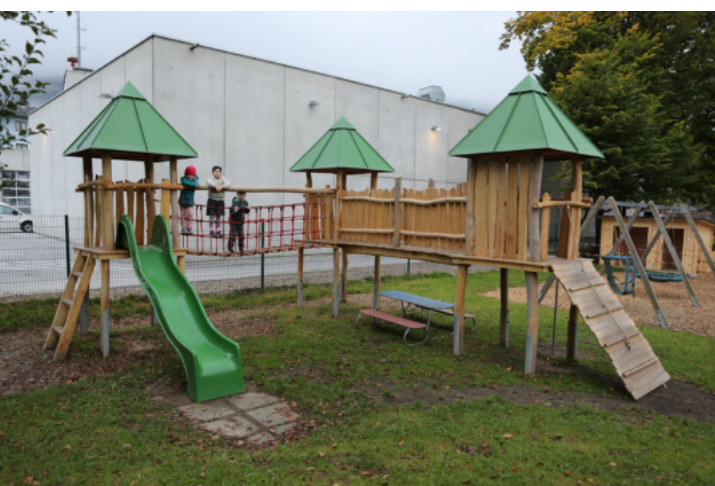
Bauliche Maßnahmen im Kindergarten Mitterhoferweg
